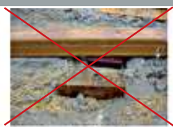
Nezalevejte nosníky do betonu
