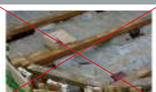
Zkontrolujte, zda jsou mezi nosníky expanzní spoje 10 mm
